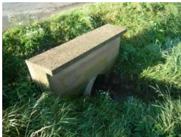
Zdj. nr 4 Przepust stan dobry
