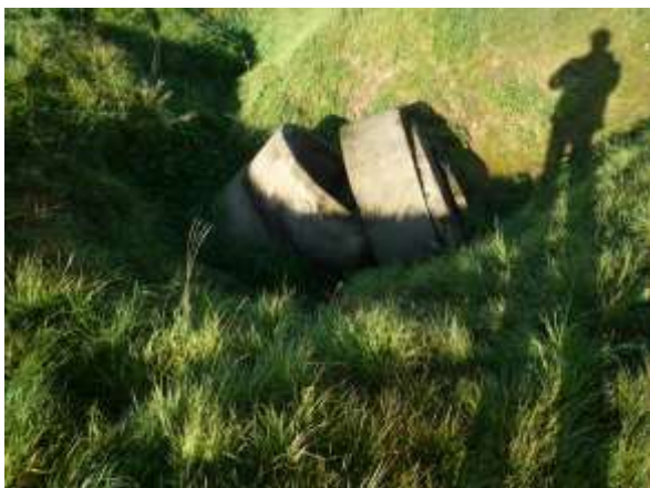
Zdj. nr 3 Studnia z rur do rozbiórki
