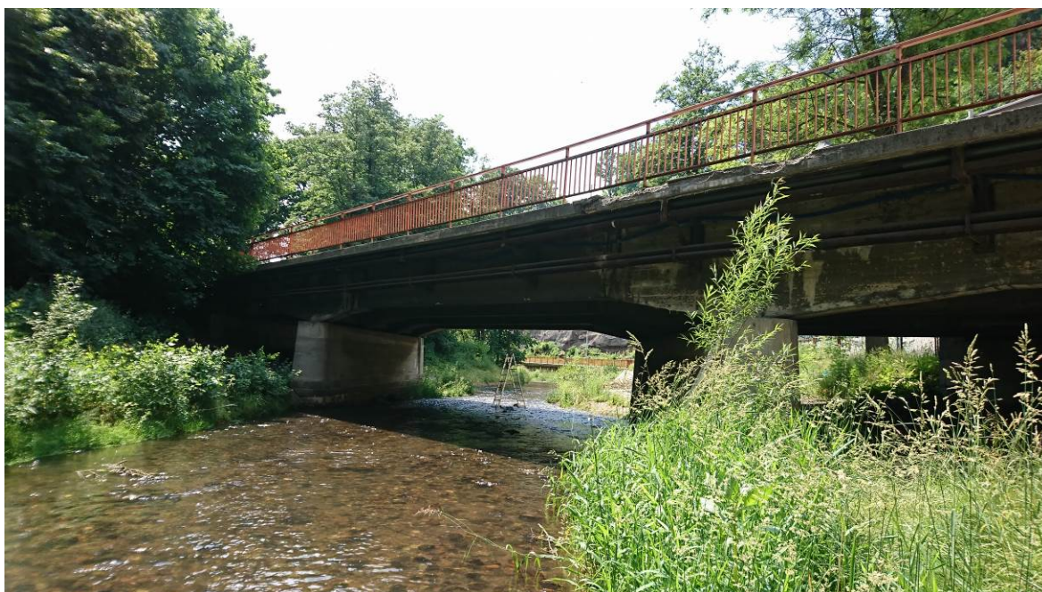
Widok z boku od strony górnej wody (GW)
