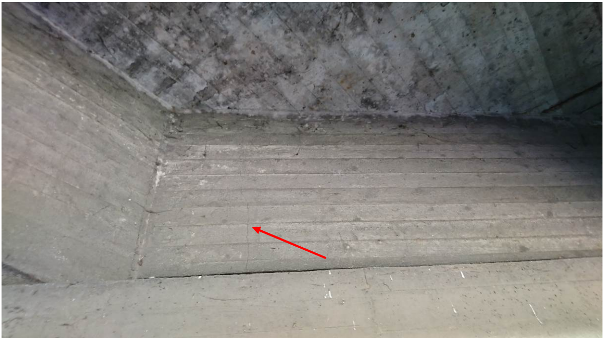
Rysa/pęknięcie skrajnej poprzecznicy nad filarem od strony Kłodzka i DW, widok w kierunku Kłodzka
