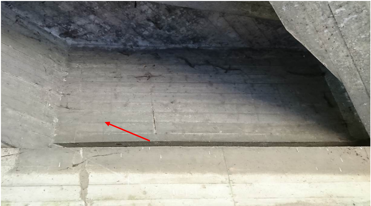
Rysa/pęknięcie środkowej poprzecznicy nad filarem od strony Kłodzka, widok w kierunku Kłodzka
