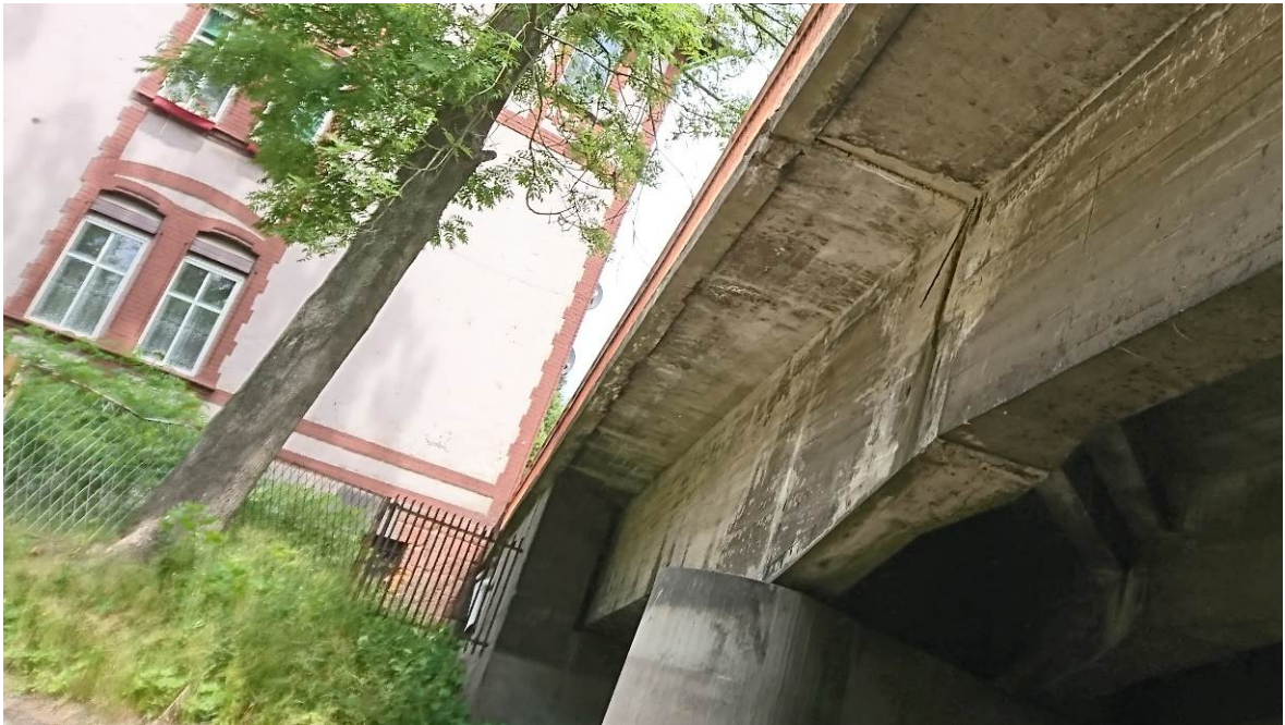
Zacieki i odbarwienia na spodzie wspornika chodnikowego oraz skrajnych belkach głównych przęseł spowodowane nieszczelnością szczelin dylatacyjnych oraz barkiem izolacji i zarysowaniem pomostu nad podporą pośrednią – widok od strony DW
