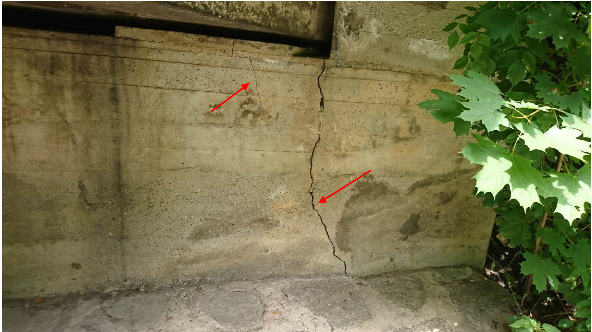
Przyczółek od strony Wałbrzycha – pionowe pęknięcie korpusu na połączeniu ze skrzydłem podpory, obok widoczne ukośne pęknięcia pod łożyskiem skrajnego dźwigara
