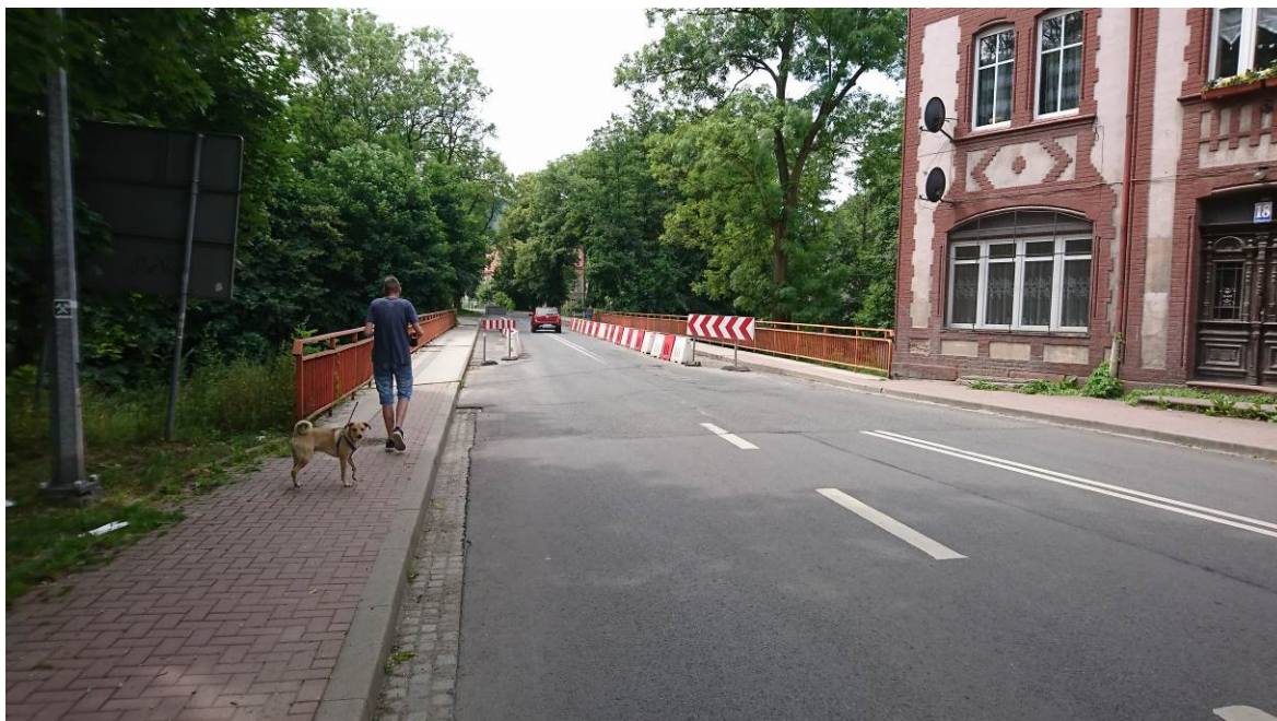
Dojazd do obiektu od strony Wałbrzycha
