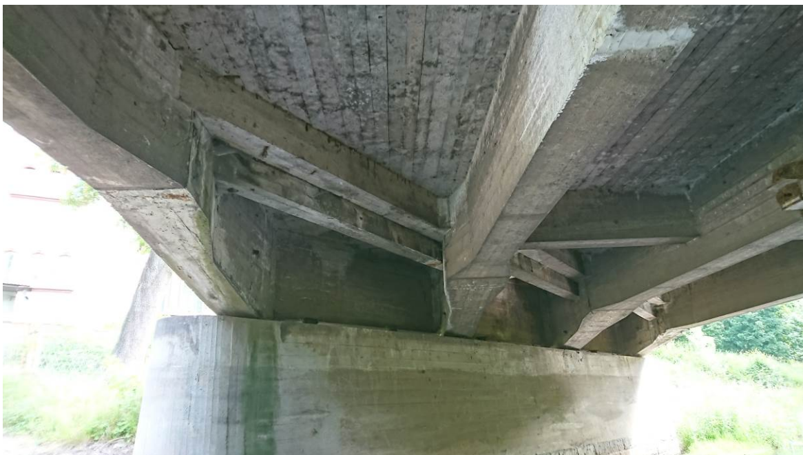
Widok na spód przęsła zawieszono i część wspornikową przęsła bocznego
