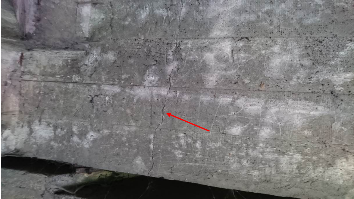
Rysa/pęknięcie środkowej poprzecznicy nad przyczółkiem od strony Wałbrzycha
