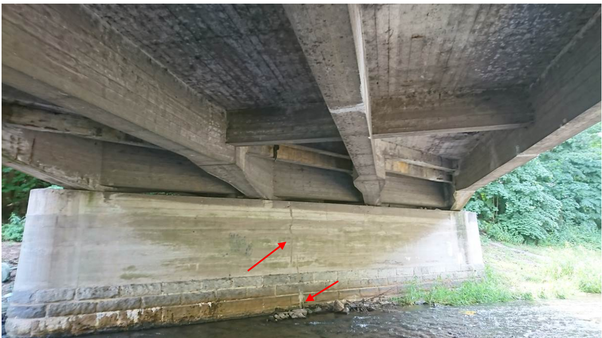
Filar od strony Kłodzka – pionowe pęknięcie pomiędzy środkowymi dźwigarami z widocznym wypełnieniem po wcześniejszej naprawie
