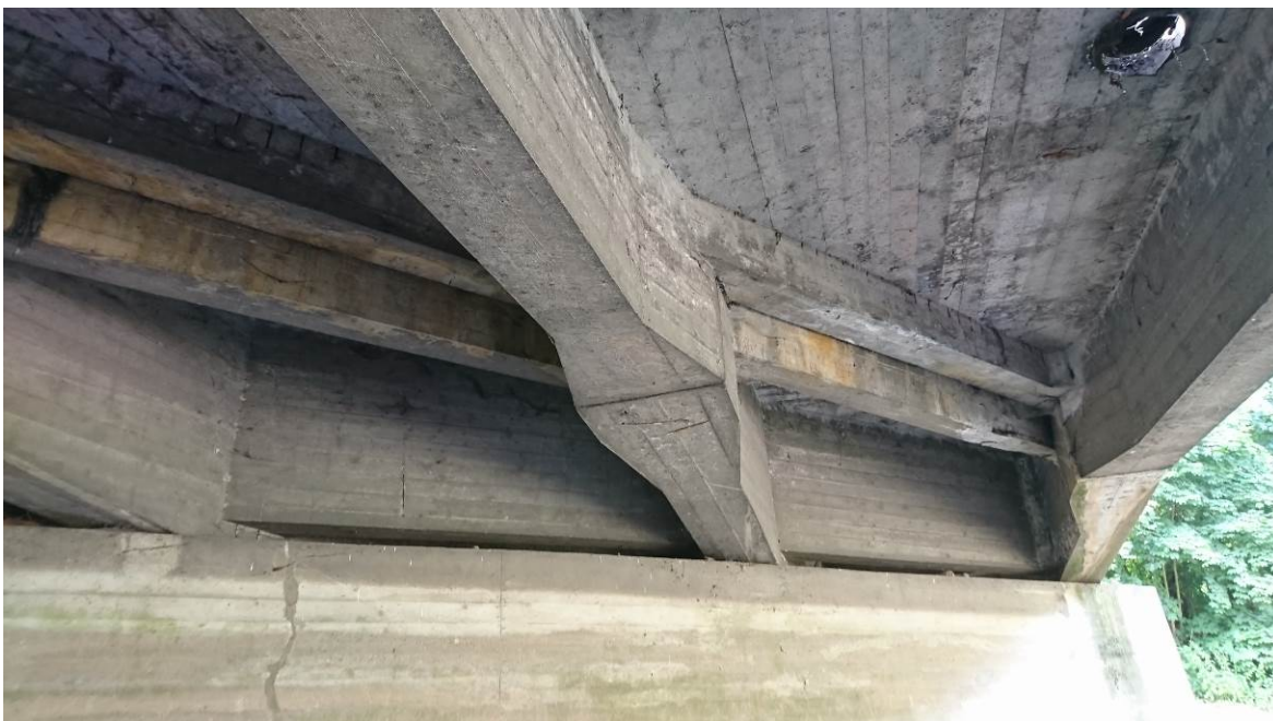
Rdzawe i wapienne zacieki na skrajnych poprzecznicach przęseł spowodowane przeciekami wody opadowej przez nieuszczelne przekrycia szczelin dylatacyjnych pomostu, uszkodzone elementy systemu odwodnienia
