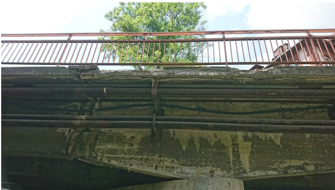
Znaczne ubytki i wykruszenia betonowego gzymsu – wspornik chodnikowy nad filarem od strony Wałbrzycha, widok od strony GW
