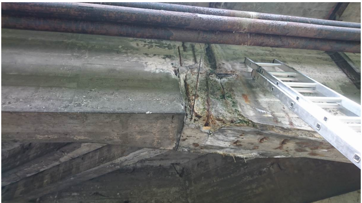
Przegub Gerbera od strony Wałbrzycha i GW (w najgorszym stanie) – zaawansowana korozja i degradacja betonu wspornikowej części przęsła, zaawansowana korozja zbrojenia strzemion (do przerywania ciągłości), ocena stanu zbrojenia głównego wymagała odkrywki
