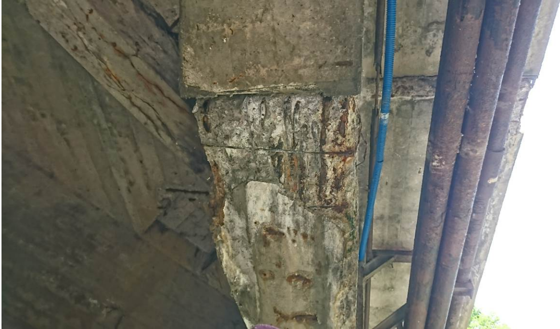
Lokalizacja j.w. – po odkryciu zbrojenia głównego okazało się, że korozja prętów głównych jest minimalna i możliwe jest dalsze wykorzystanie konstrukcji po stosownych naprawach i wzmocnieniach
