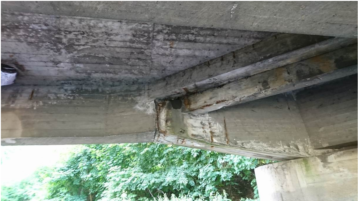
Uszkodzenia j.w. oraz dodatkowo zaawansowana korozja zbrojenia poprzecznicy i wspornikowej części skrajnego dźwigara przęsła od strony GW
