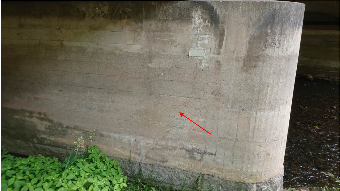
Filar od strony Wałbrzycha, widok w kierunku Kłodzka – pod skrajnym dźwigarem widoczne jest ukośne pęknięcie, przebiegające przez całą wysokość korpusu podpory, szklana plomba bez uszkodzeń
