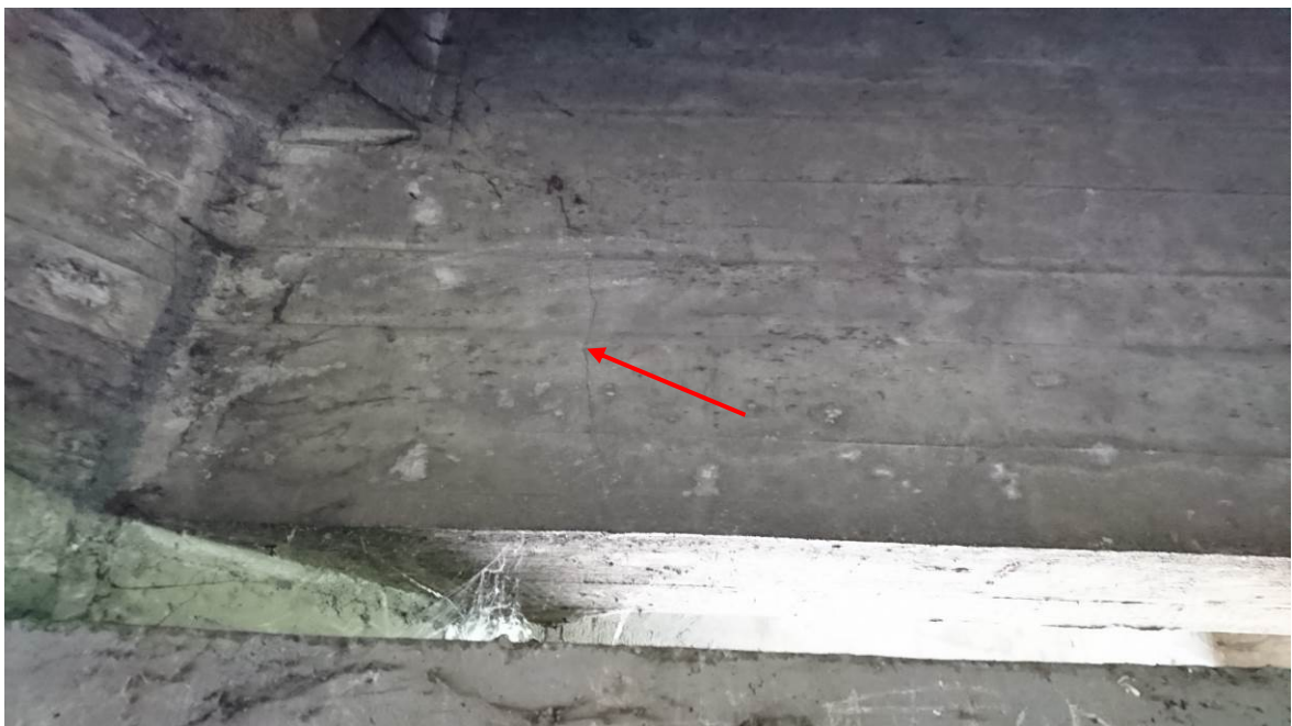
Rysa/pęknięcie środkowej poprzecznicy nad filarem od strony Kłodzka, widok w kierunku Wałbrzycha
