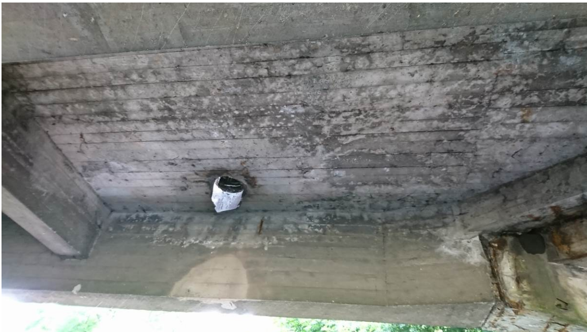
Uszkodzenia j.w., zniszczone elementy systemu odwodnienia są przyczyną zaciekania wód opadowych na boczną i dolną powierzchnię dźwigara głównego (odbarwienia)
