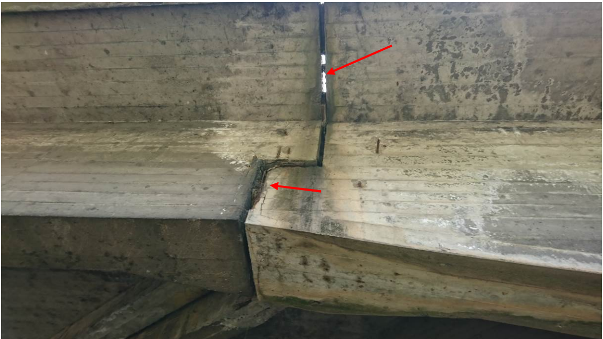
Zacieki i odbarwienia na spodzie płyty wspornika chodnikowego oraz skrajnych dźwigarach przęseł, korozja i ubytki betonowej otuliny oraz korozja zbrojenia w okolicy przegubu – uszkodzenia spowodowane brakiem uszczelnienia szczeliny dylatacyjnej
