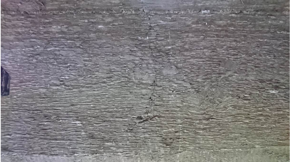
Pionowe zarysowanie na wewnętrznej powierzchni skrajnego dźwigara przęsła zawieszonoego od strony DW, uszkodzenie zlokalizowane w okolicy połowy rozpiętości
