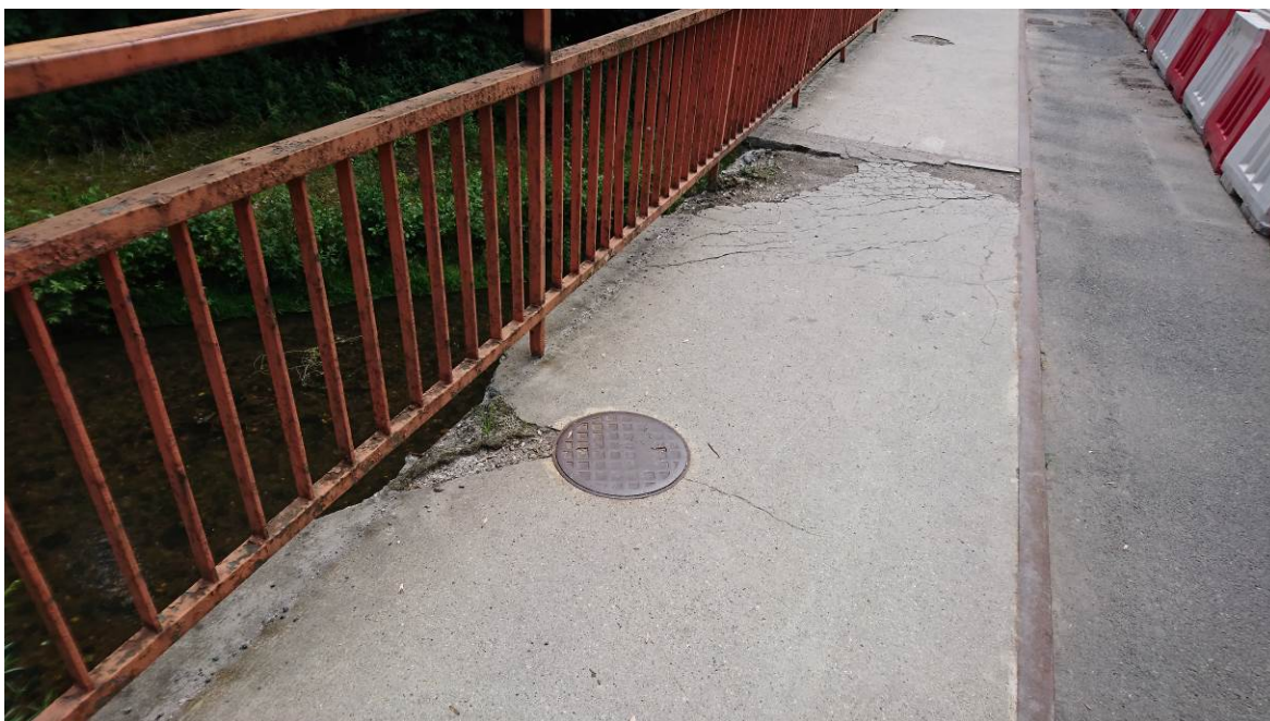
Znaczne ubytki i wykruszenia betonowego gzymsu – wspornik chodnikowy nad filarem od strony Wałbrzycha, widok w kierunku Kłodzka, korozja na elementach balustrady
