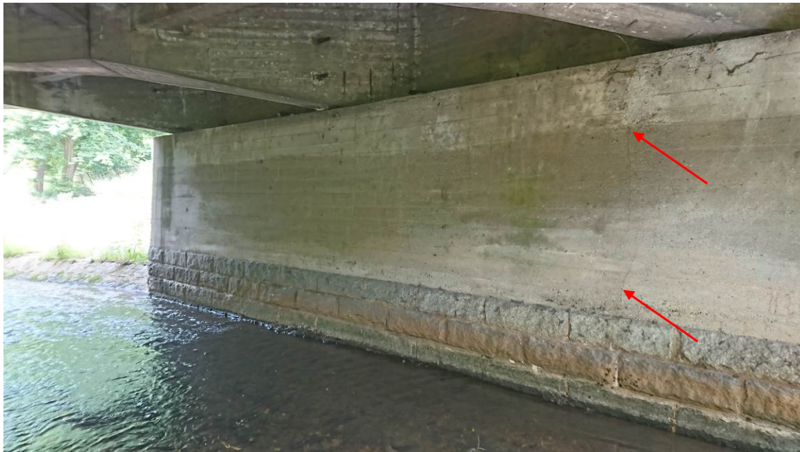
Filar od strony Wałbrzycha – pionowe pęknięcie pod środkowym dźwigarem
