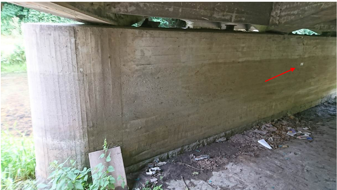
Filar od strony Wałbrzycha, widok w kierunku Kłodzka – pionowe pęknięcie pod środkowym dźwigarem
