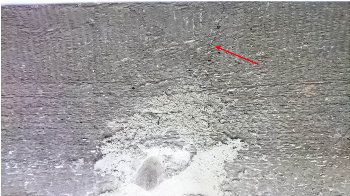
Pionowe zarysowanie w środkowej części skrajnego dźwigara przęsła zawieszono od strony DW, poniżej miejsce naprawy po odkrywce zbrojenia
