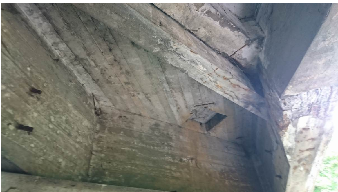
Zacieki i odbarwienia na poprzecznicach i dźwigarach głównych w okolicy przegubu, znaczna degradacja i ubytki powierzchniowych warstw betonu, rdzawe wykwity na poprzecznicach świadczą o korozji zbrojenia, na wsporniku belki odsłonięte zbrojenie
