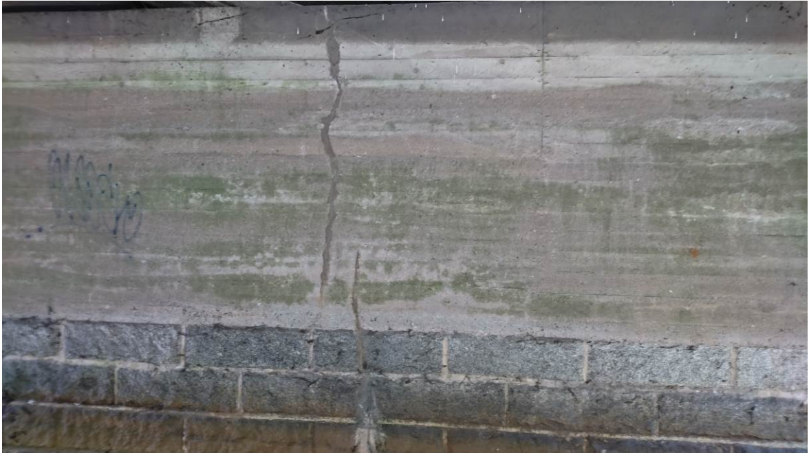
Filar od strony Kłodzka – uszkodzenie j.w. (zbliżenie)
