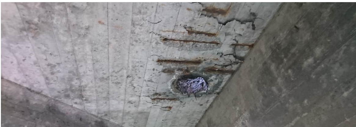
Brak rury spustowej (obcięta lub obłamana), zaawansowana korozja powierzchniowa i odspajanie się betonowej otuliny oraz korozja stali zbrojeniowej
