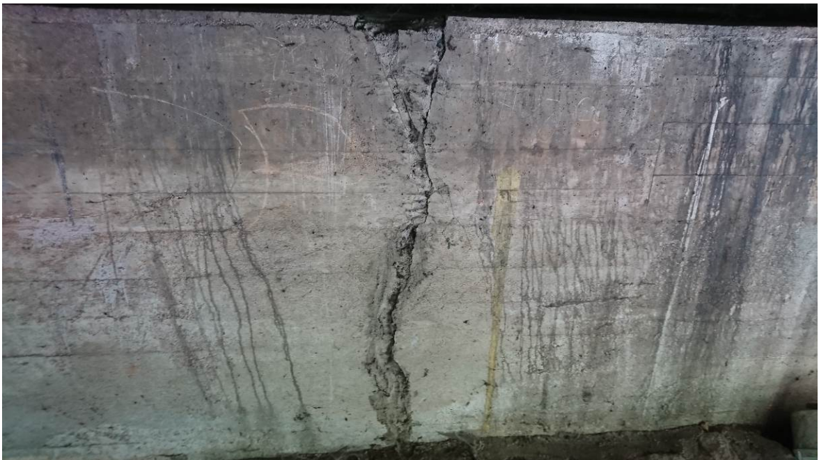
Przyczółek od strony Wałbrzycha – pęknięcie korpusu pomiędzy środkowymi dźwigarami przęśła z widocznym wypełnieniem uszkodzenia
