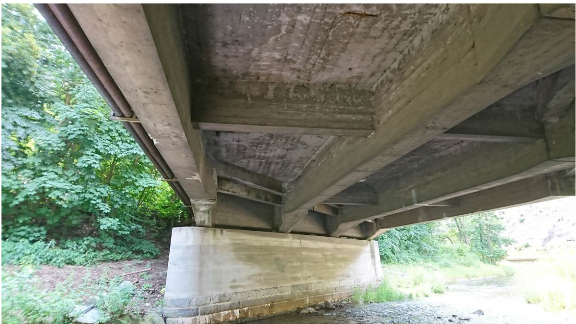
Spód przęsła zawieszonoego, widok w kierunku Kłodzka – przecieki i odbarwienia na spodzie płyty pomostowej oraz miejscowe ubytki betonowej otuliny z odsłoniętym, skorodowanym zbrojeniem
