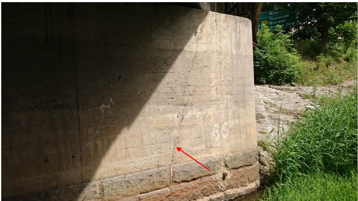
Filar od strony Wałbrzycha – pod skrajnym dźwigarem widoczne jest ukośne pęknięcie, przebiegające przez całą wysokość korpusu podpory
