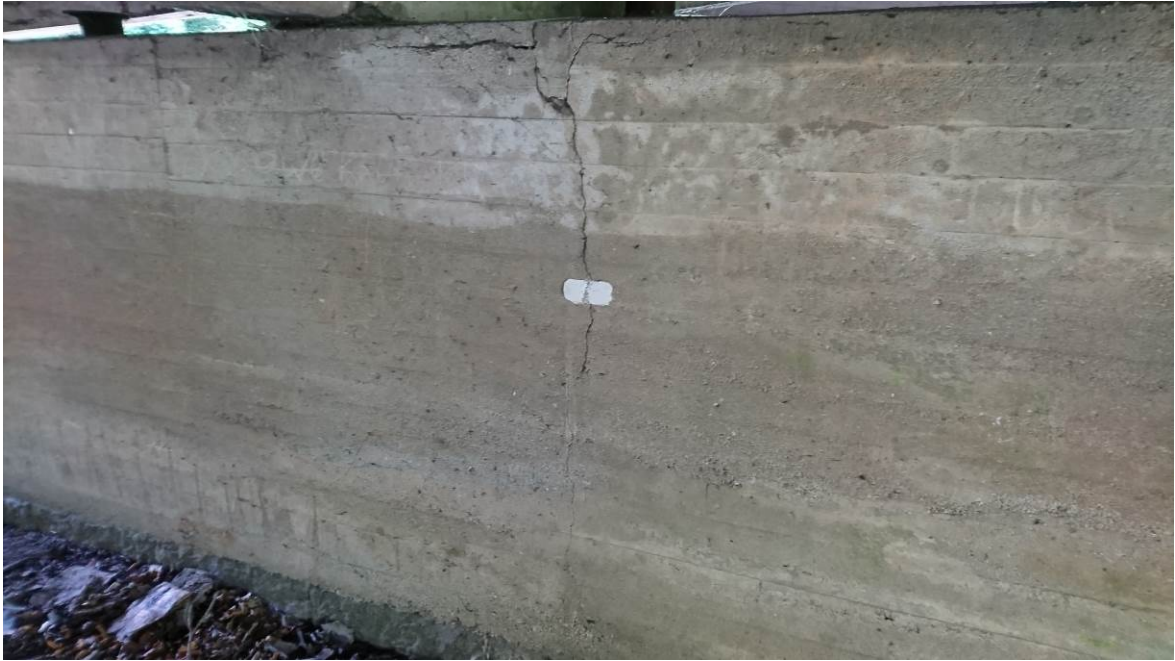
Filar od strony Wałbrzycha, widok w kierunku Kłodzka – pionowe pęknięcie korpusu podpory, brak szklanej plomby
