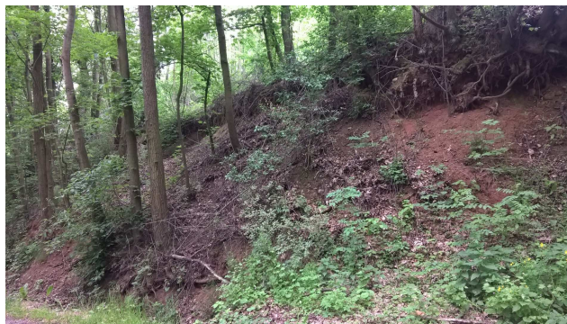
Fot. 3. Obrywy, osunięcia materiału gruntowego ze skarpy.
