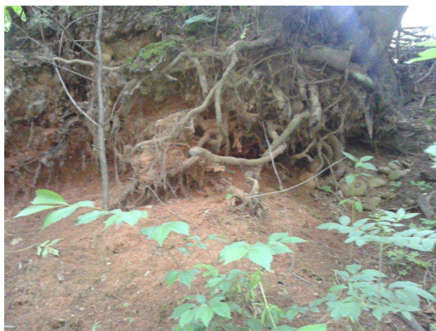
Fot. 5. Widoczny system korzeniowy w 45% odsłonięty, pozbawiony gruntu organicznego. Korzenie wiszą w powietrzu nie mając oparcia o podłoże.
