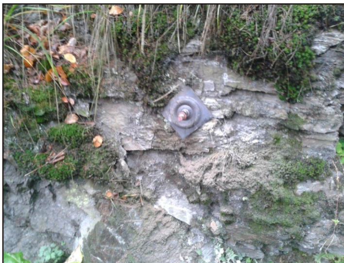
Fot.15. Międzygórze. Droga nr 3232D. Kotwa D-18 mm z podkładką w ścianie skalnej.
