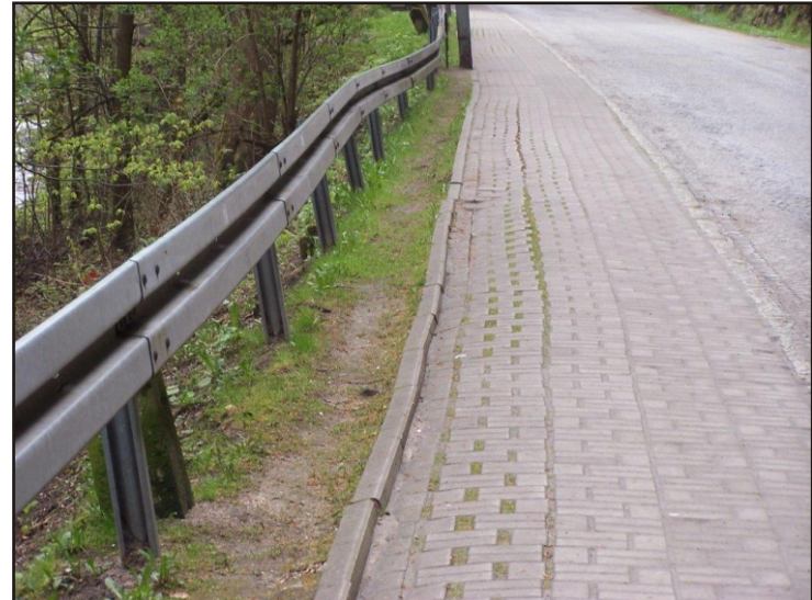
Fot.2. Widoczna zniekształcona barierka energochłonna na skutek przemieszczonych mas gruntowych. Niestabilna kostka i krawężniki w chodniku. Widoczne koleiny oraz odspojenia w kostce brukowej.
