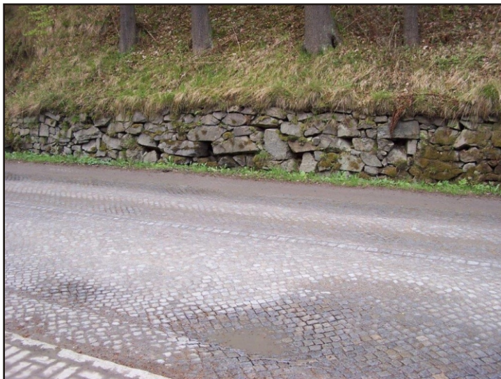
Fot.3. Widok muru oporowego wykonanego z bloków granitognejsu z ubytkami bloczków kamiennych w ścianie muru oporowego. Widoczne koleiny na prawym pasie jezdni, na lewym zastoiska wody w obniżeniach, koleinach nawierzchni drogi.
