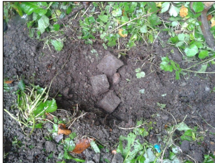
Fot.10. Międzygórze. Droga nr 3232D. Koryto rowu wyłożone kostką granitową na zaprawie betonowej.
