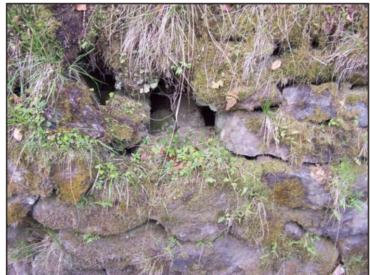
Fot.4. Mur oporowy na przeciwstoku o grubości 0,70 - 1,00m i wysokości 2,00 - 2,20m. Widoczne ubytki bloczków skalnych. Za ścianą wewnętrzną muru pustki o grubości 0,10 - 0,20m.
