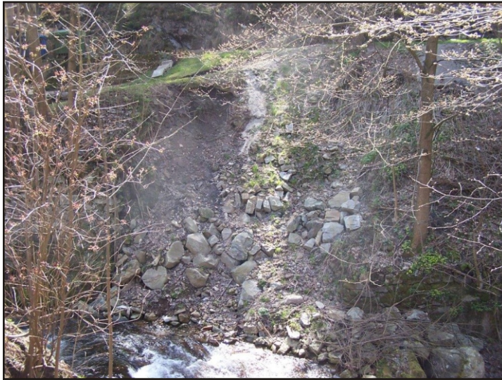
Fot.1. Międzygórze. Droga nr 3232D. Panorama na osuwisko. Nisza osuwiska w rejonie budynku nr 10 przy ul. Wojska Polskiego. Widoczne bloki kamienne-pozostałość po ścianie muru oporowego.
