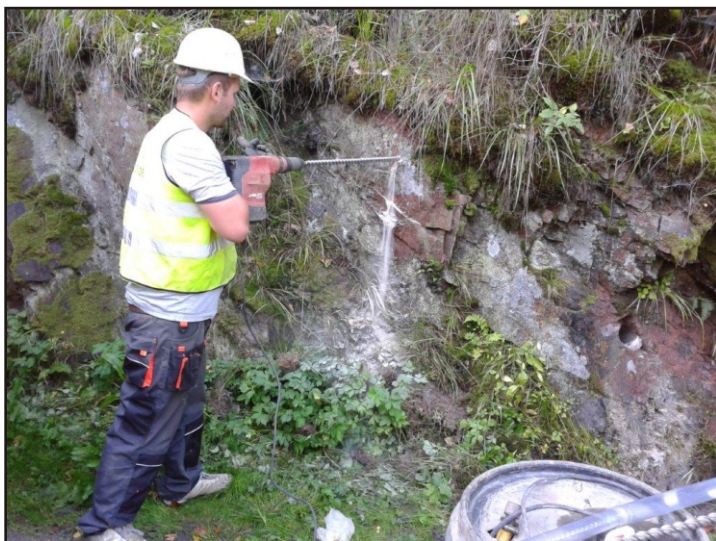
Fot.11. Międzygórze. Droga nr 3232D. Wiercenie otworu D-24 mm pod kotwytę L=1,50 m.
