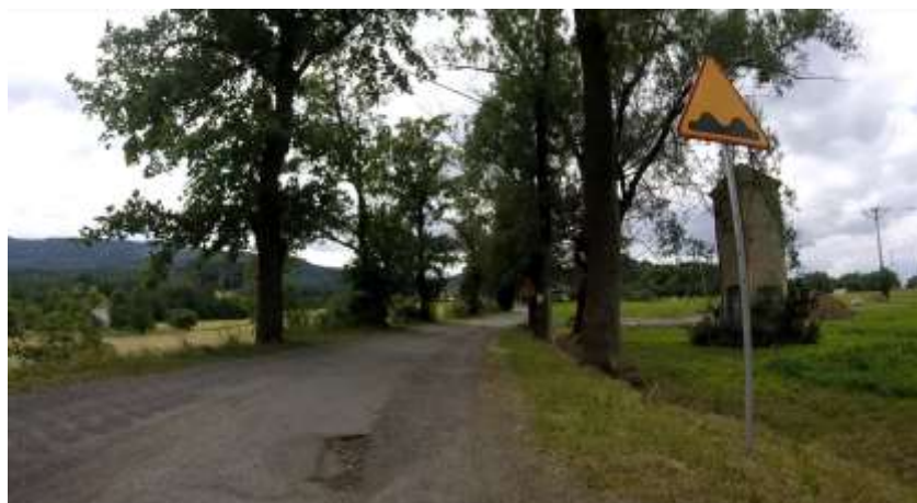
Zdj. nr 2 Początkowy odcinek drogi
