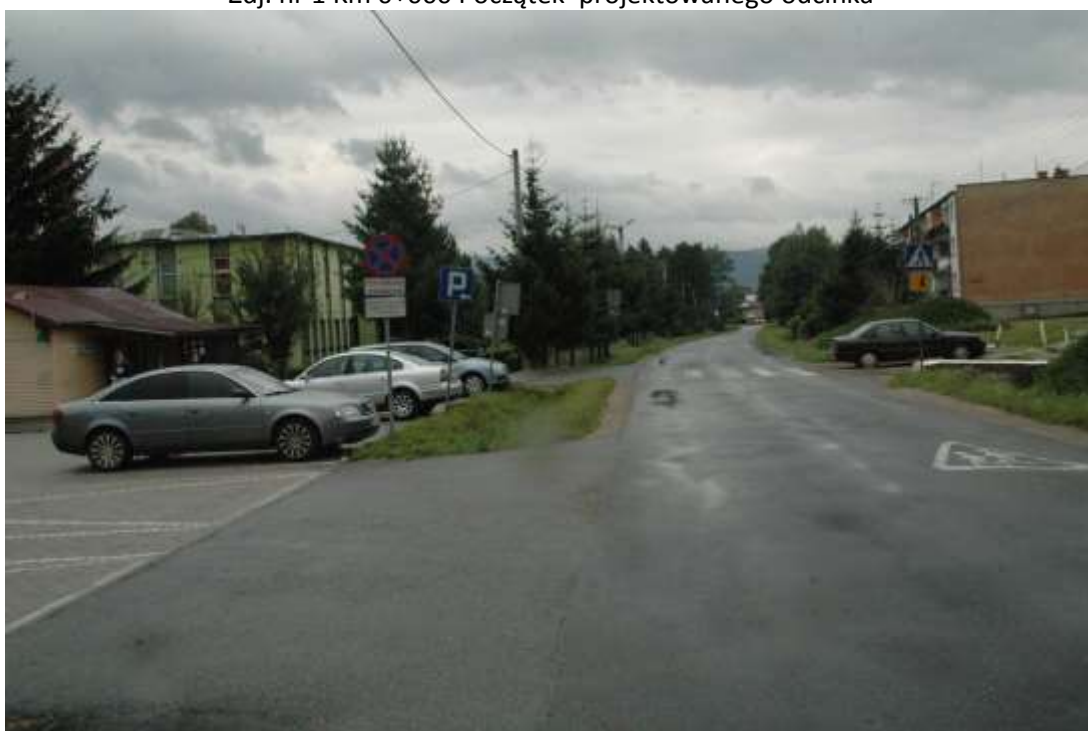
Zdj. nr 2 Początkowy odcinek drogi
