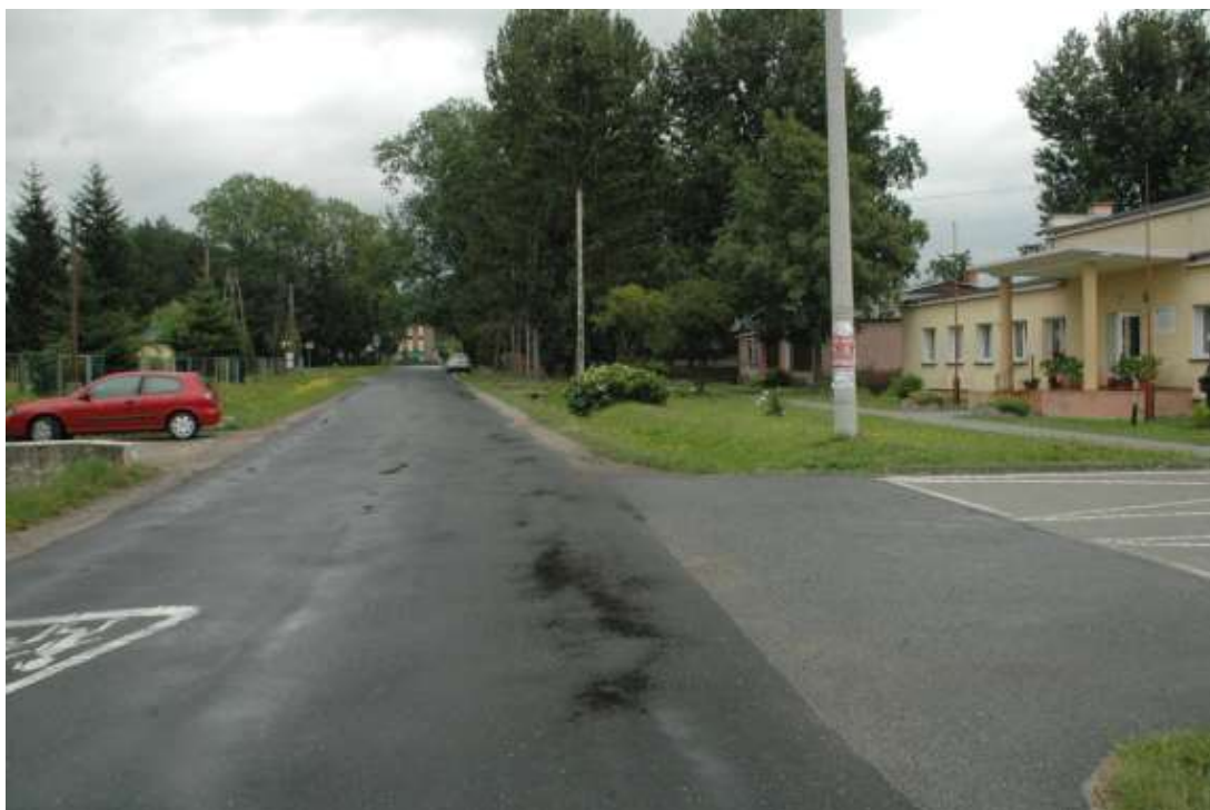
Zdj. nr 1 Km 0+000 Początek projektowanego odcinka
