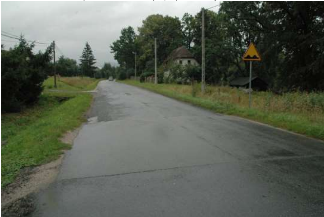
Zdj. nr 4 Koniec pierwszego odcinka
