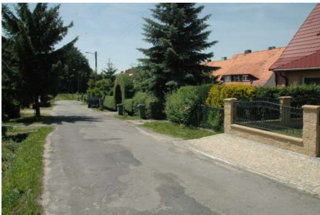
Zdj. nr 4 Środkowa część projektowanego odcinka
