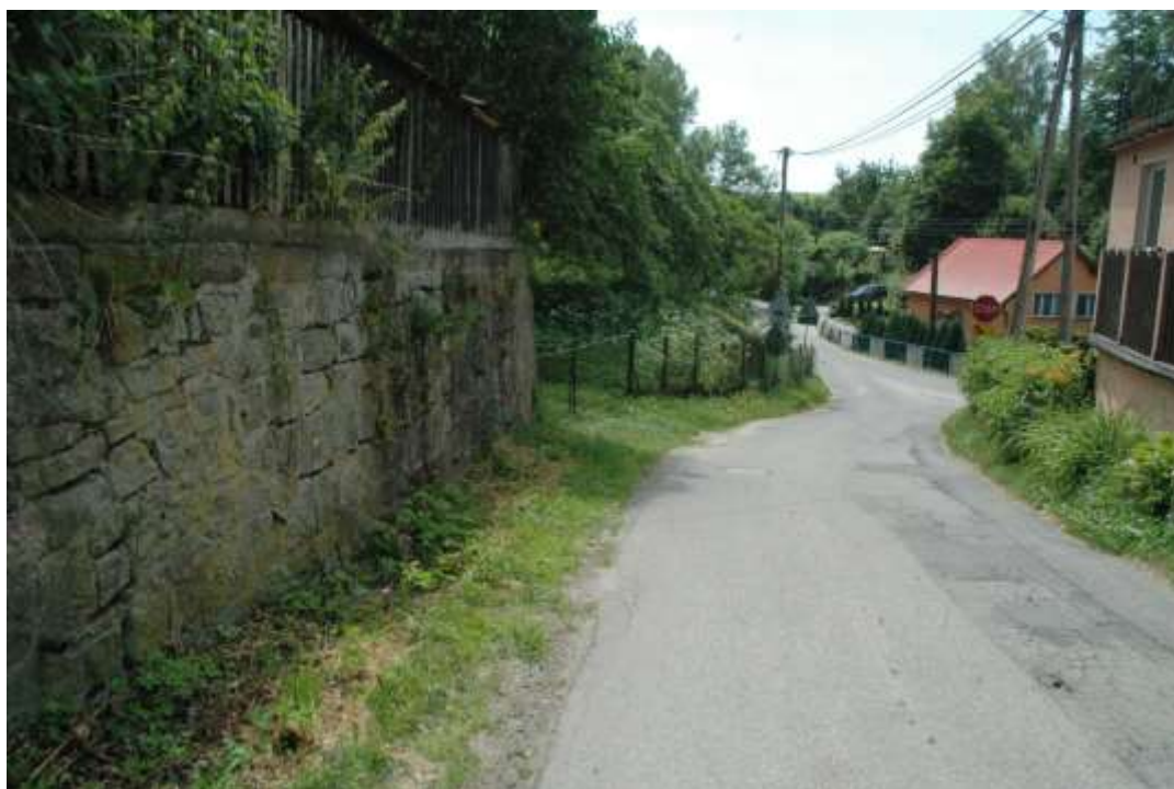
Zdj. nr 6 Koniec projektowanego odcinka
