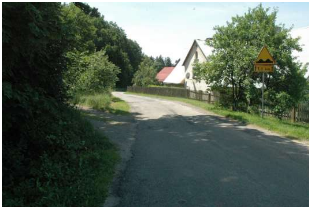
Zdj. nr 5 Końcowa część drogi
