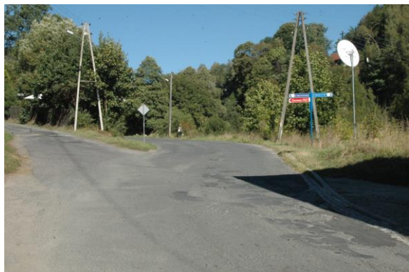
Zdj. nr 1 Km 0+000 Początek projektowanego odcinka drogi
