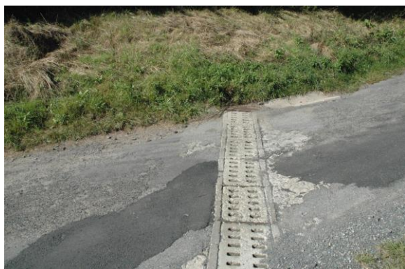
Zdj. nr 2 Istniejący ściek skrzynkowy
