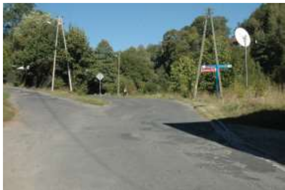
Zdj. nr 1 Km 0+000 Początek projektowanego odcinka drogi
