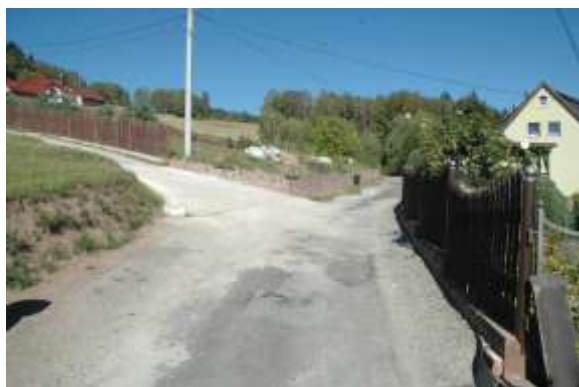
Zdj. nr 6,7 Końcowa część drogi
