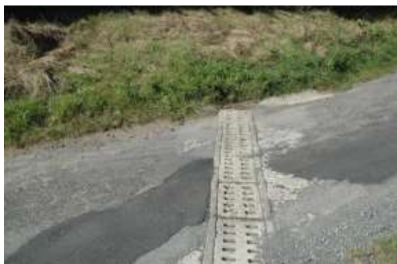
Zdj. nr 2 Istniejący ściek skrzynkowy
