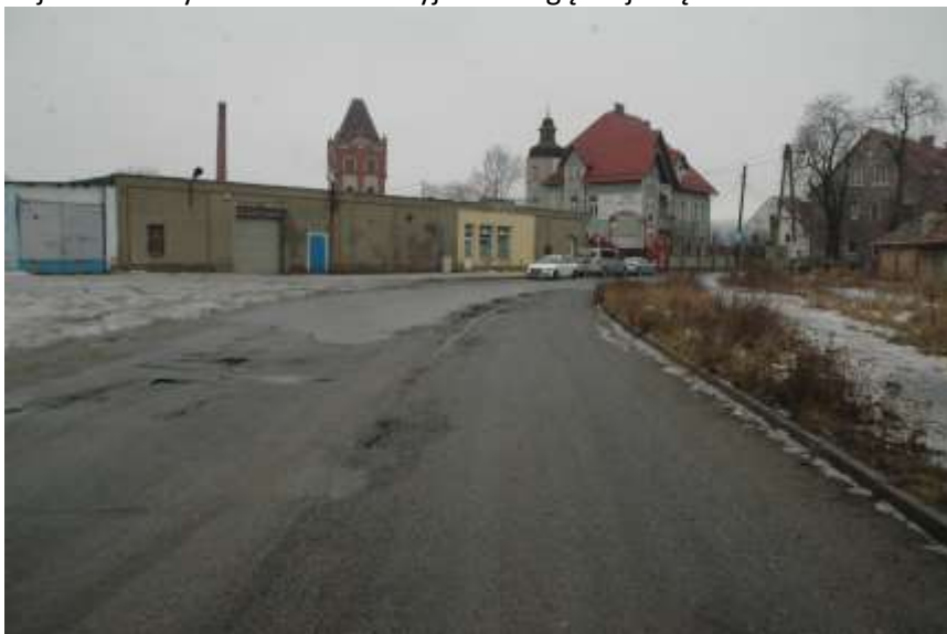
Zdj. nr 7 Końcowa część drogi
