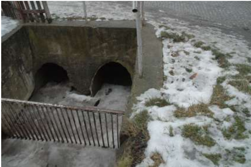
Zdj. nr 5 Istniejący przepust oczkowy do przebudowy
