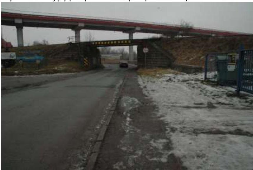
Zdj. nr 6 Skrzyżowanie bezkolizyjne z drogą krajową nr 8
