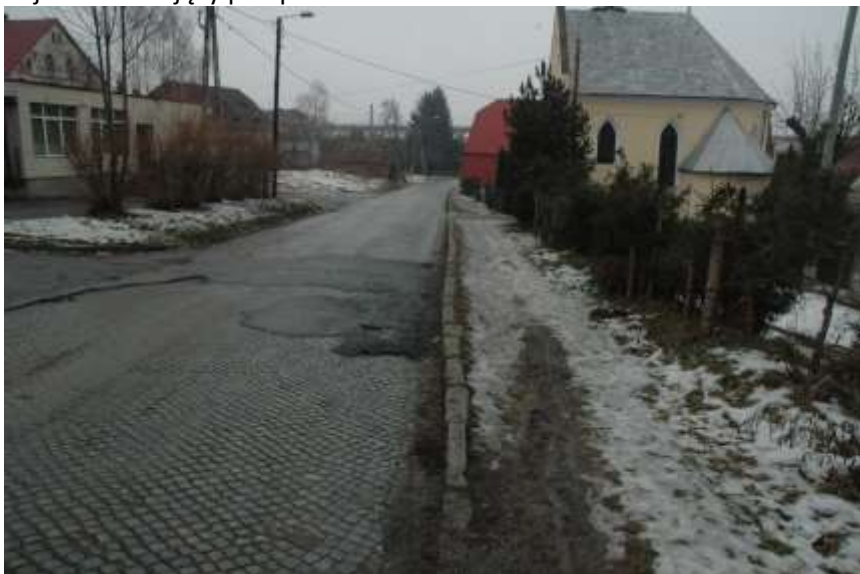
Zdj. nr 4 Środkowa część projektowanego odcinka
