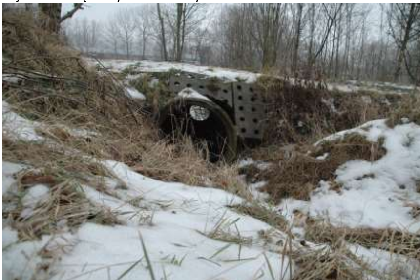
Zdj. nr 3 Istniejący przepust w km 0+096 do remontu
