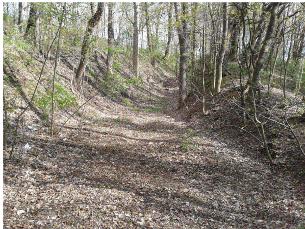
Fot. 7. Wąwóz o szerokości 4,00-6,00 m. Po lewej stronie skarpa drogi powiatowej nachylenie skarp 1:1,0 do 1:1,5.
