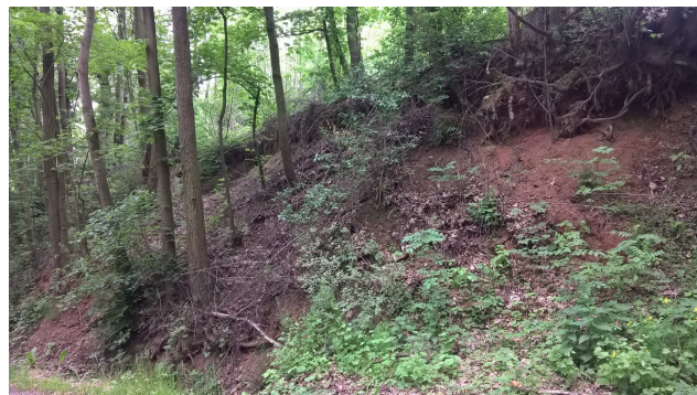
Fot. 3. Obrywy, osunięcia materiału gruntowego ze skarpy.
