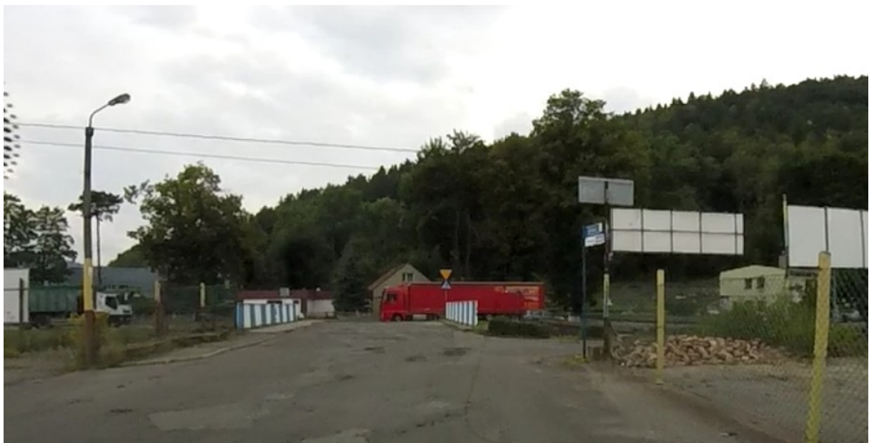
Przebudowa drogi powiatowej nr 3319D - ulica Górnicza w miejscowości Nowa Ruda
