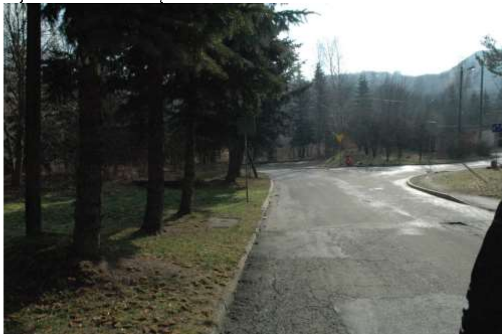
Zdj. nr 4 Koniec projektowanego odcinka
