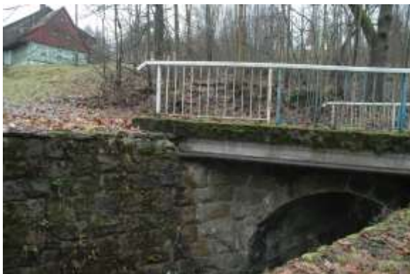
Zdj nr 7 Obiekt mostowy
