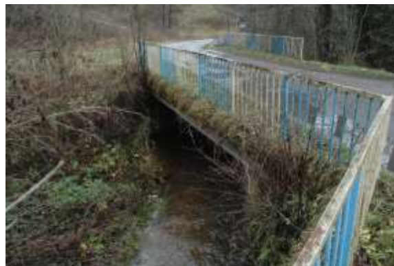
Zdj. nr 8 Obiekt mostowy
