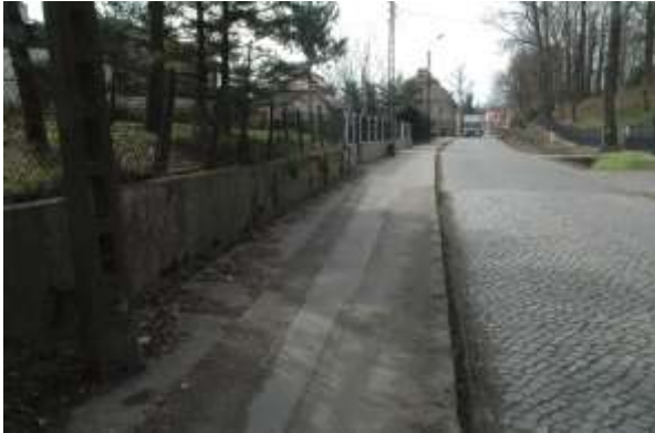
Zdj. nr 1 Km 0+000 Początek projektowanego odcinka drogi
