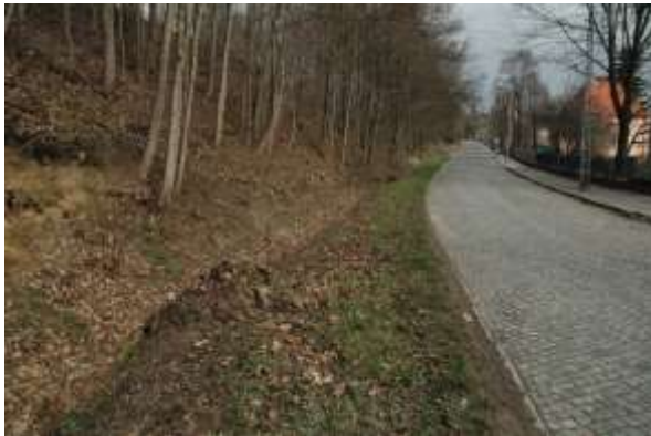
Zdj. nr 2 Środkowa część drogi
