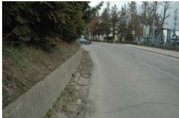
Zdj. nr 6 Końcowa część drogi
