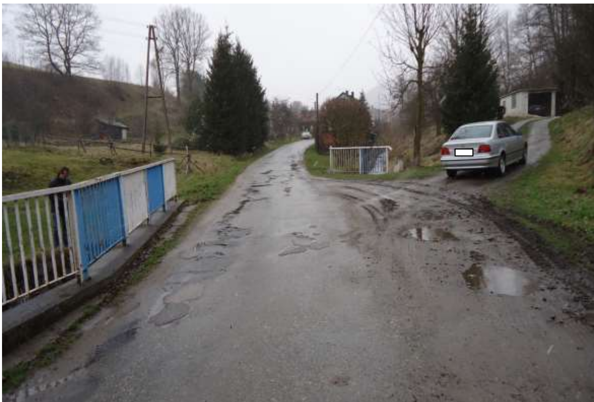
fot. 1– widok na pomost przedmiotowego obiektu w kierunku Nowej Wsi i Woliborza ( t.j. w stronę górnej wody )
