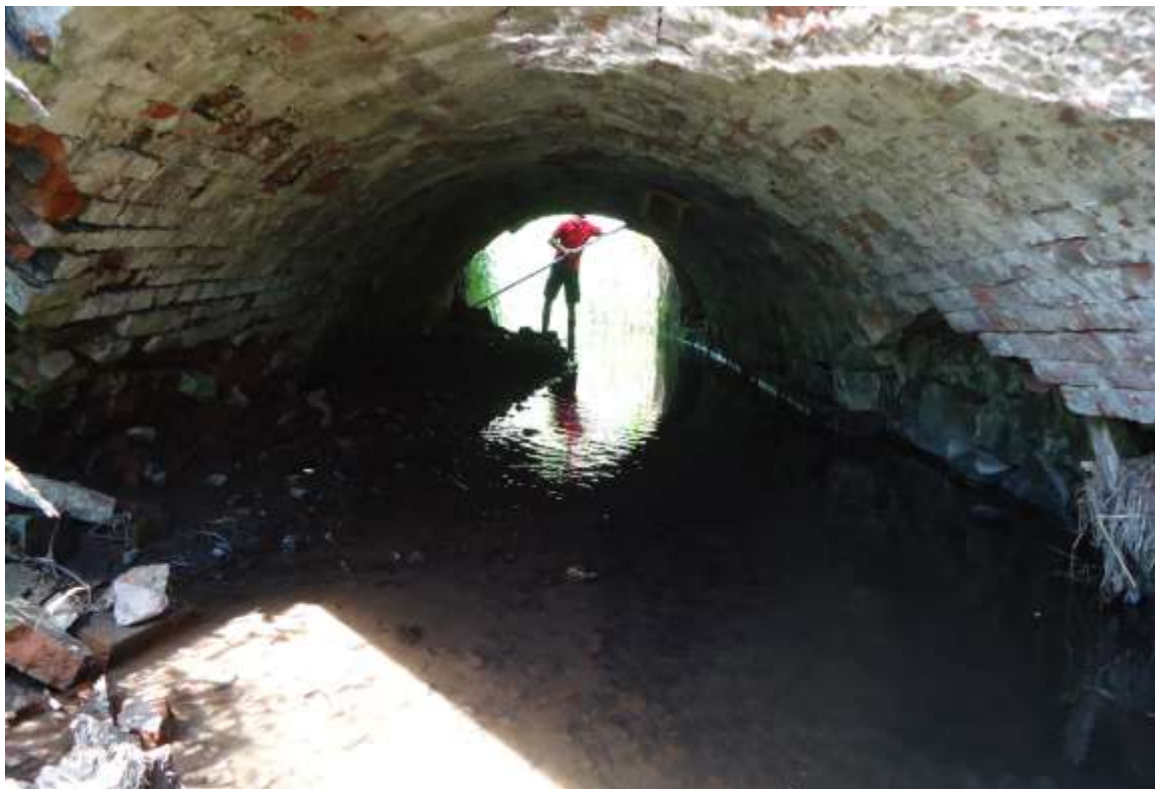
fot. 8 – widok zniszczonej konstrukcji nośnej mostu widzianej od strony wylotowej w kierunku górnej wody
