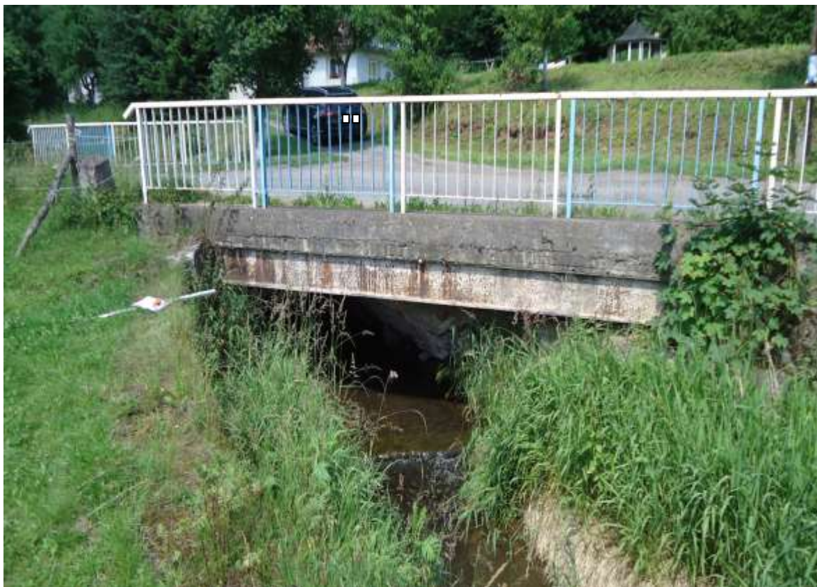
fot. 5 – widok wylotu istniejącego obiektu z charakterystycznym wzmocnieniem konstrukcji
