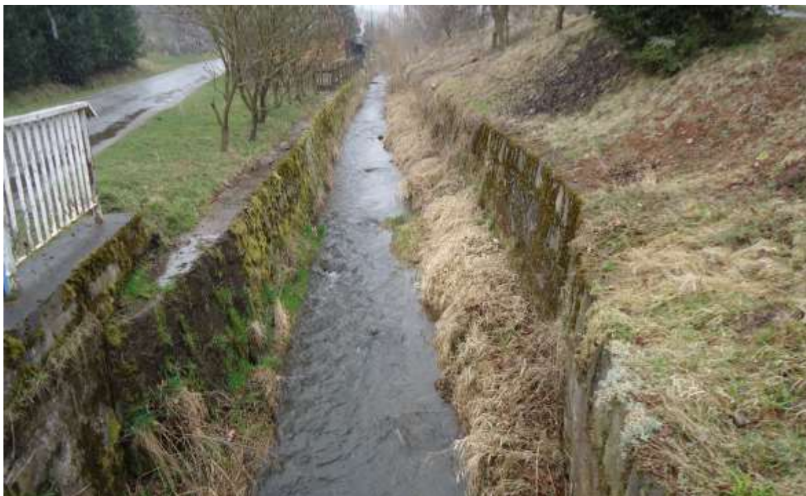
fot. 3 – widok koryta cieku w kierunku górnej wody – istniejące mury regulacyjne Potoku Czerwionka w kierunku Nowej Wsi
