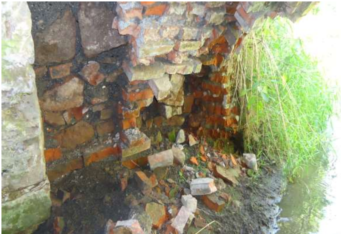
fot. 7 – widok na uszkodzoną część konstrukcji mostu w kierunku wlotu
