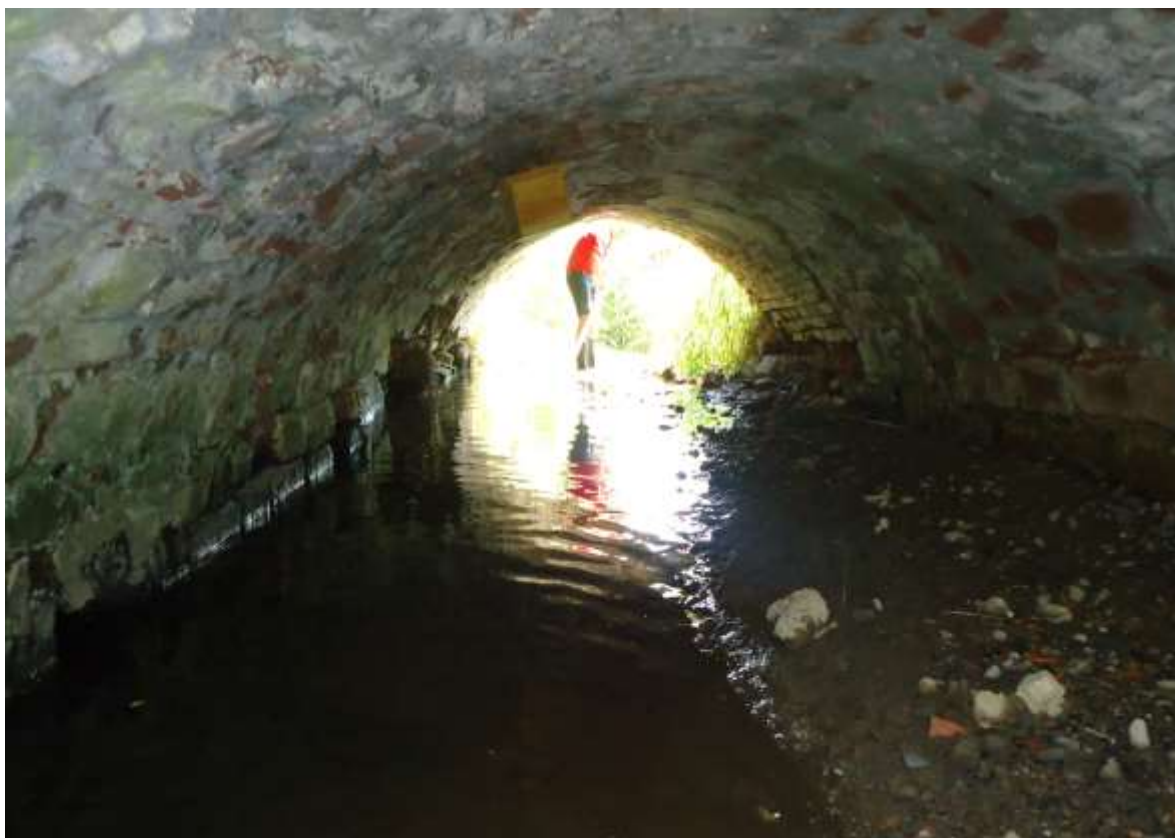
fot. 6 – widok wnętrza konstrukcji mostu widzianego w kierunku górnej wody
