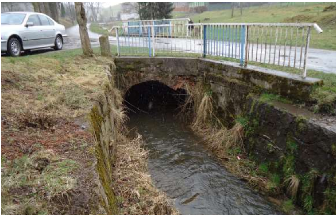
fot. 2 – widok ogólny wlotu mostowego – t.j. od strony górnej wody w kierunku Bożkowa
