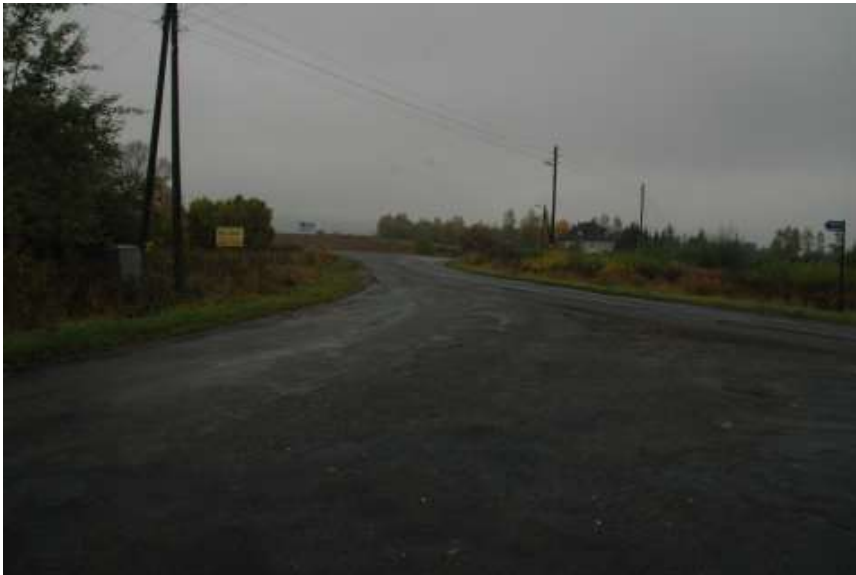
Zdj. nr 1 Km 0+000 Początek projektowanego odcinka drogi
