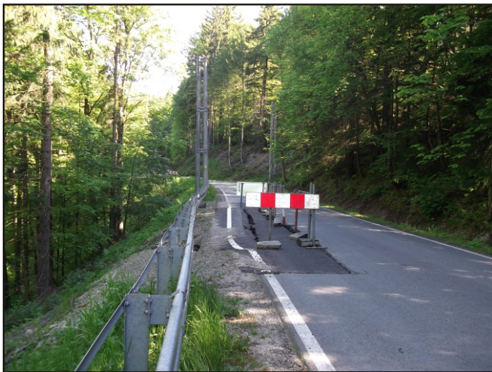
Fot.1. Panorama ogólna. Rejon powstałego osuwiska.
