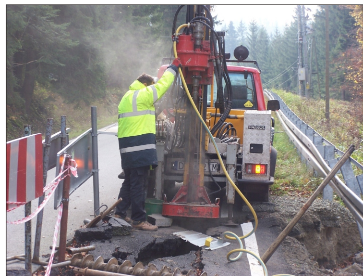
Fot.11. Wiercenie skał od głębokości 3,00 - 7,00 m. p.p.t. za pomocą młotka udarowego.
