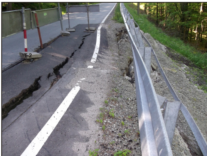
Fot.6. Widoczny zrekonstruowany a obecnie uszkodzony fragment jezdni asfaltowej w postaci łąty o długości 17,50 m..
