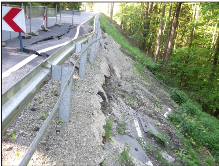
Fot.4. Widoczna zniekształcona barierka energochłonna na skutek przemieszczonych mas gruntowych.
