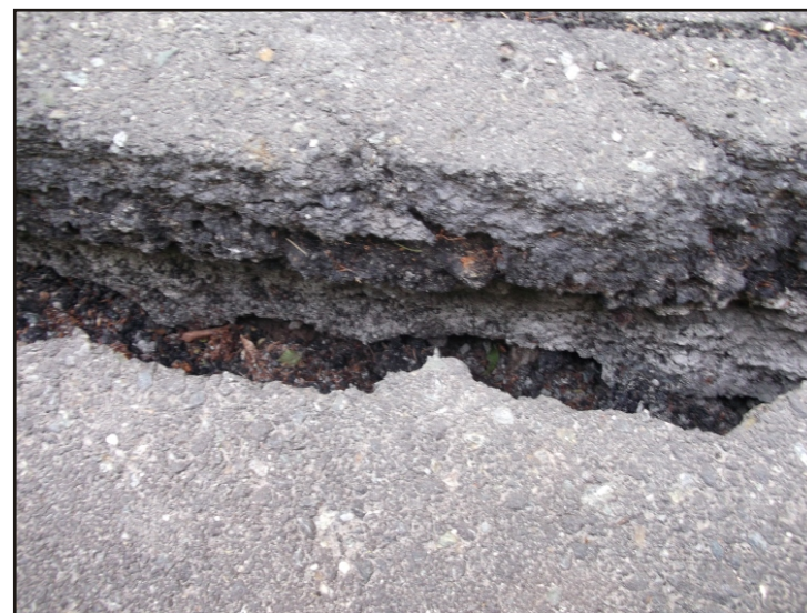
Fot.7. Szczeliny i pęknięcia w jezdni asfaltowej oraz podbudowie drogi o długości 10,50m, osiagające 0,50 m głębokości, powstałe w wyniku osunięcia się gruntu.
