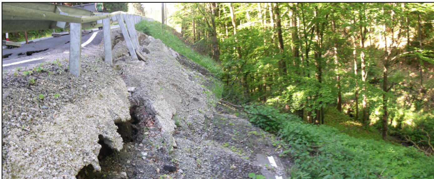
Fot.3. Panorama ogólna. Widok ugięcia nawierzchni asfaltowej, zbocze stromej skarpy oraz cieku wodnego u podnóża zbocza. Wyraźna kawerna o charakterze infiltracyjnym wody opadowej z rowu przyskarpowego.
