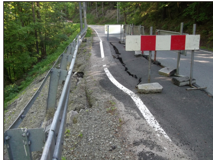
Fot.2. Widoczne ugięcie nawierzchni asfaltowej.
