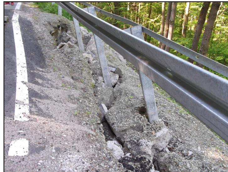
Fot.5. Uszkodzona podbudowa drogi.
