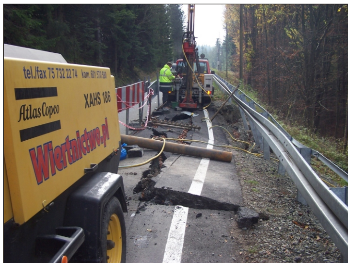
Fot.10. Prace terenowe. Wiercenie otworu O-2.
