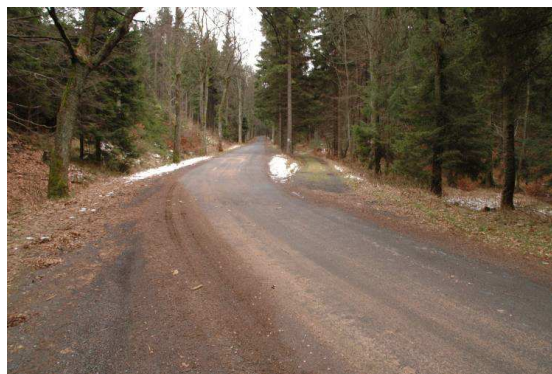
Zdj. nr 4 Środkowy odcinek drogi
