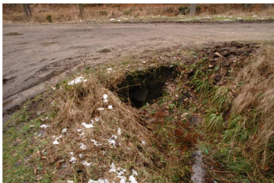
Zdj. nr 3 Istniejący przepust Ø 60 cm do przedłużenia
