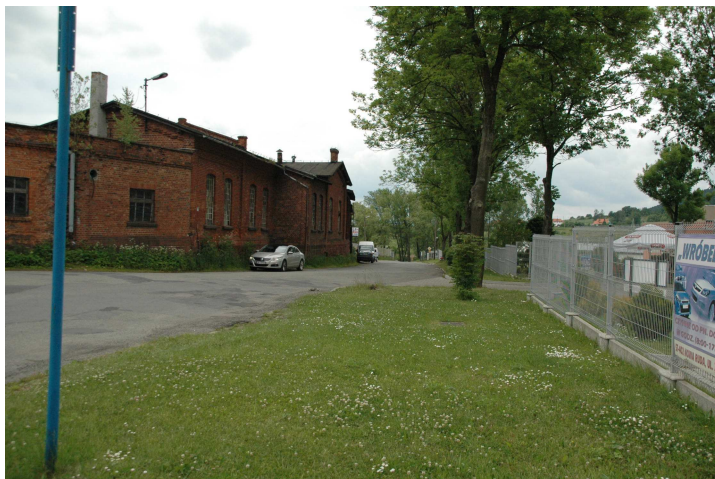
Zdj.nr 2 Początkowa część drogi.
