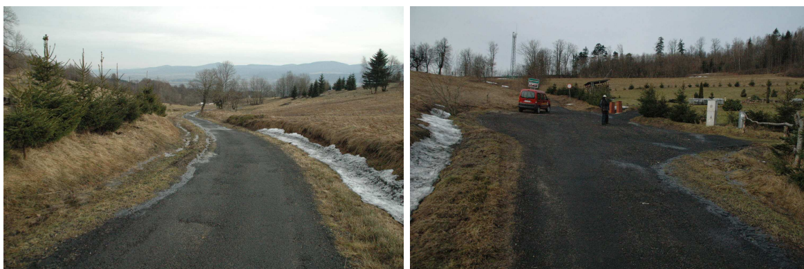
Zdj.nr 1 Km 0+000 Początek projektowanego Zdj.nr 2 Początkowa część drogi. odcinka.
